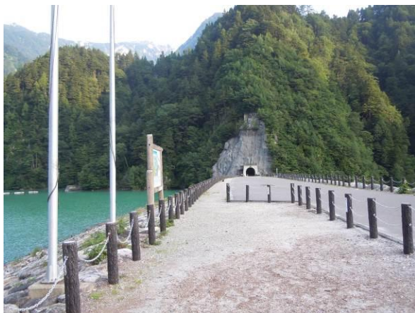
高瀬ダムの上 トンネルに向かう
