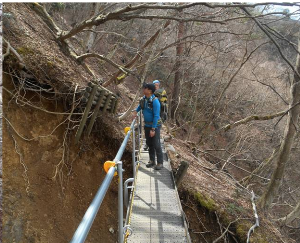
登山道が崩落し橋が設置されている
