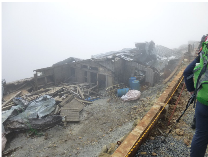
御嶽剣ヶ峰山荘 解体中
