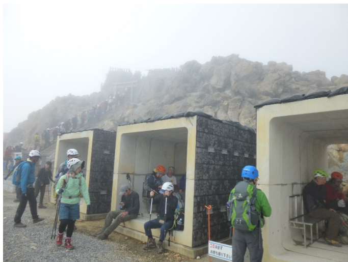
新しく設置されたシェルター3基 90人避難可能
