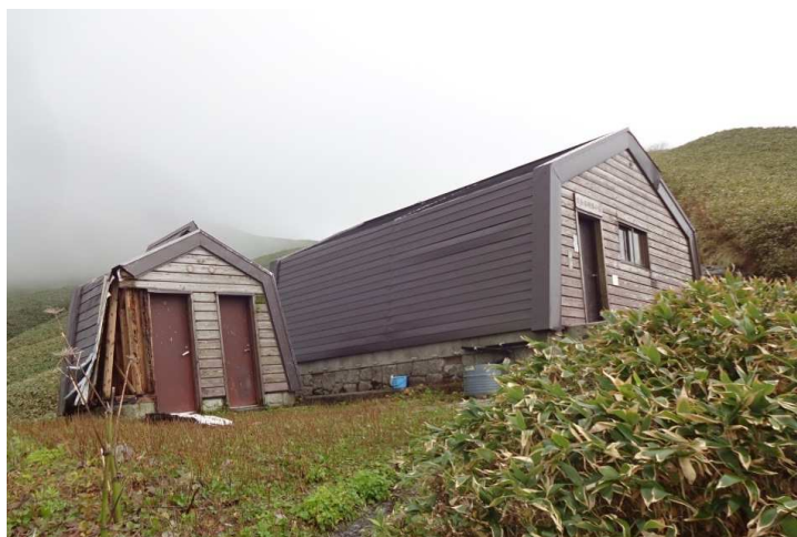
トイレ棟が台風にて破損していた
