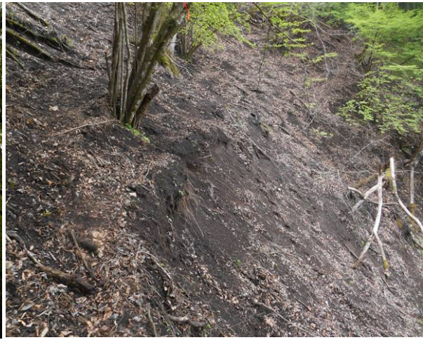
相変わらず崩落場所が多くある
