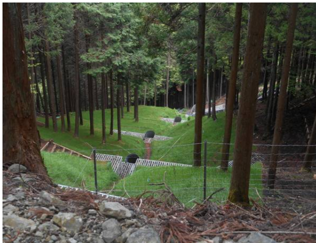
フェンスの中は崩落対策の緑地です
