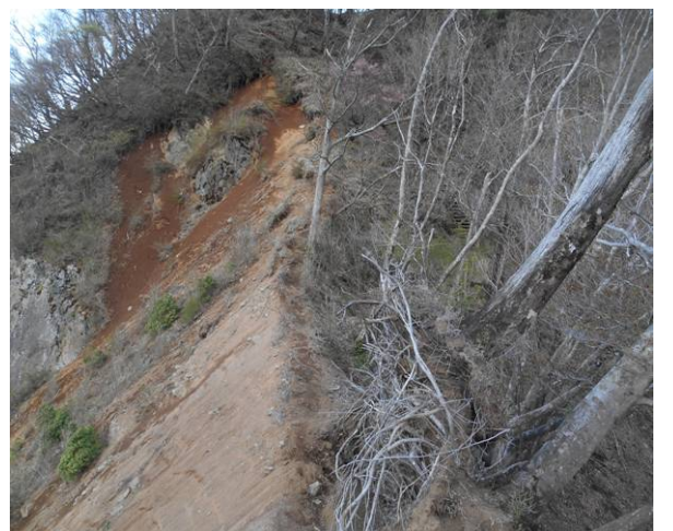
昔の登山道跡、崩落しています道は右側に新しい道が作ってあります、
