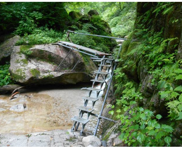
次はまだ新しい鉄の梯子と橋です
