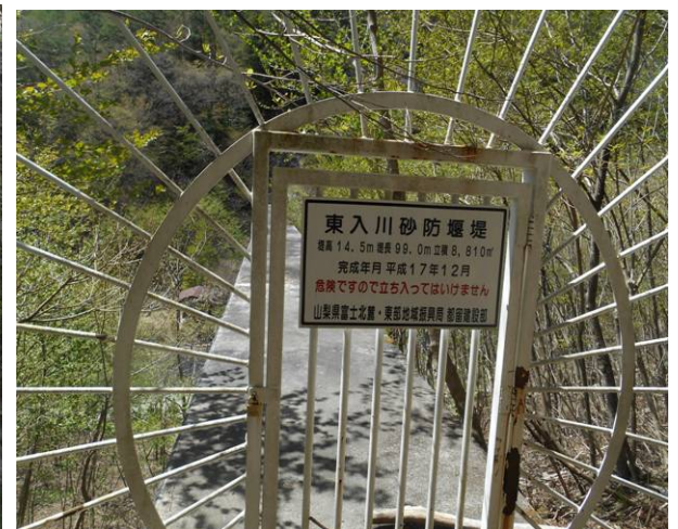
砂防堤の上部
