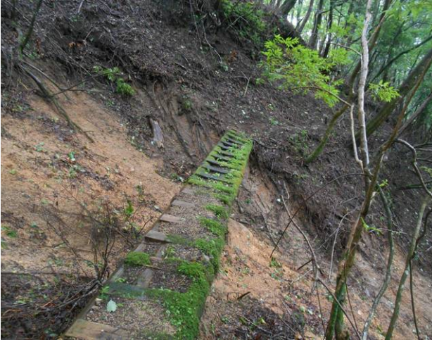
苔生した橋、小雨の為滑りやすい、 また谷側に傾いている
