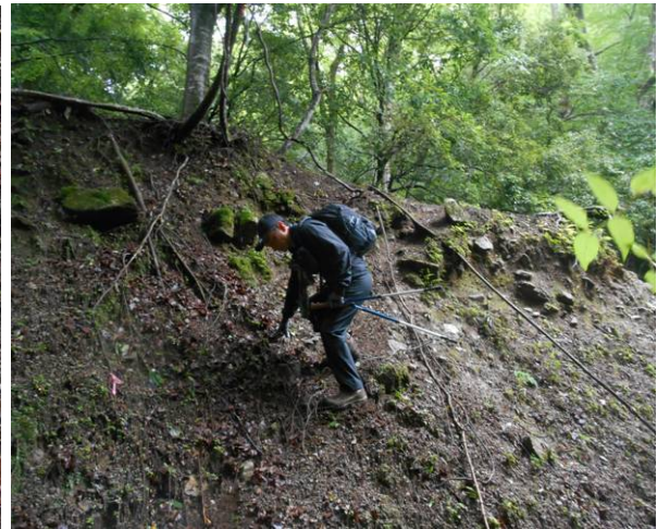
崩落個所の通過下は川で高さは数メートル
