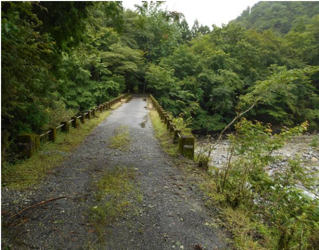
千鳥橋 正面が浅瀬橋方面
