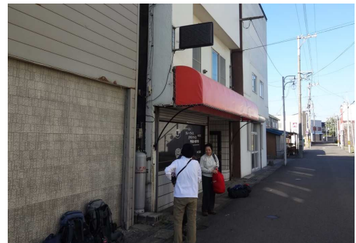
今は食堂になっている旧増毛駅舎
