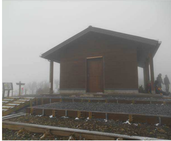
改修中の避難小屋 左右には窓が付き 中は明るくなった、4月より使用出来そう
