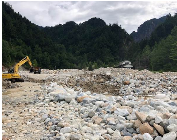
奥に見えるのが清嵐壮 橋がないので渡渉と思われたが、河原の整備中で石伝いの渡る事が出来た
