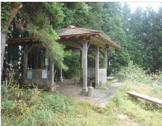
東屋の奥側が小怒田尾根の出口
