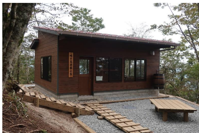
畦ヶ丸避難小屋到着 まだ工事中で月末オープンの予定 トイレ付き、以前のような悪臭無く期待大
