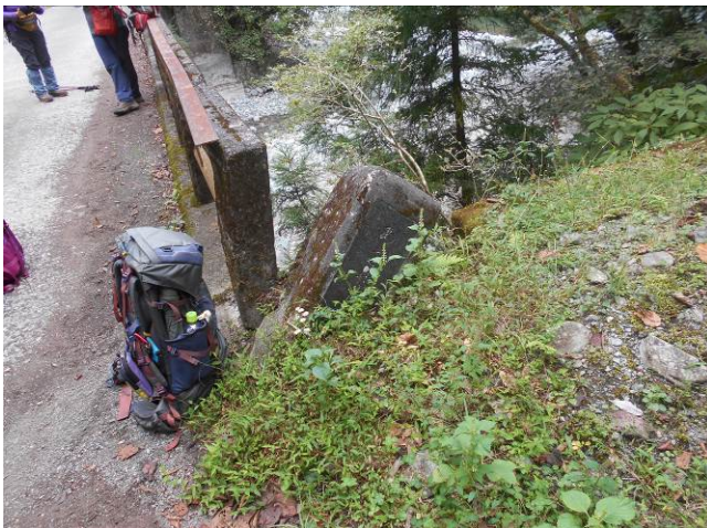
浅瀬橋から約10分位でゲートがあり 一般車両はゲートまでの通行
