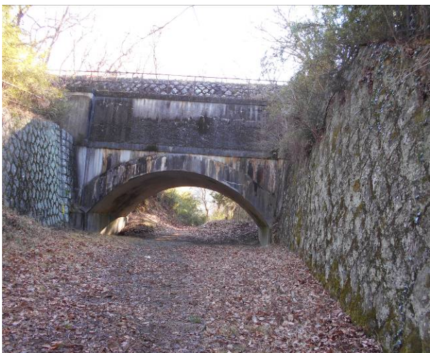
元坂分岐の水道橋
