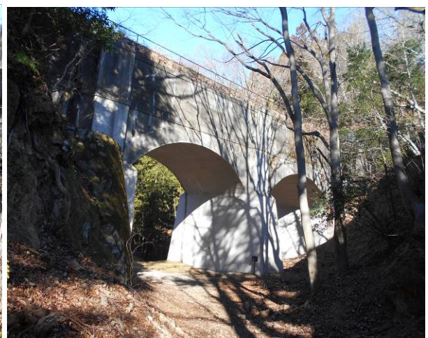
水道橋 発電所の用水路が上にある
