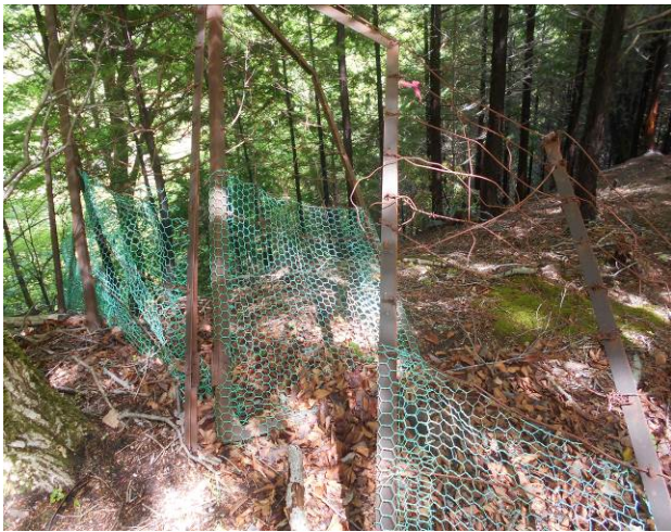
鹿柵用の扉 柵が壊れている
