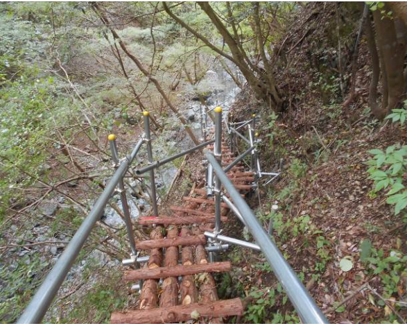
作業用に為 足場パイプで作った橋
