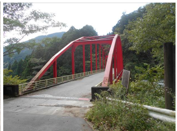
寄大橋に到着 橋を渡った所が駐車場
