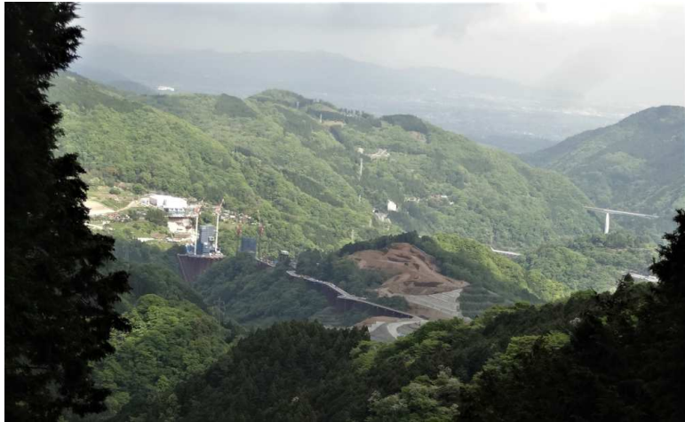
第二東名工事現場
