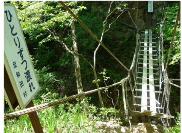
吊り橋ですが、よく揺れます
