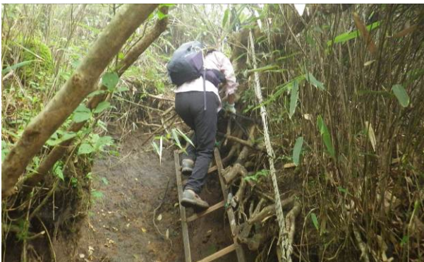
急な場所に橋が設置下の部分が浮いている
