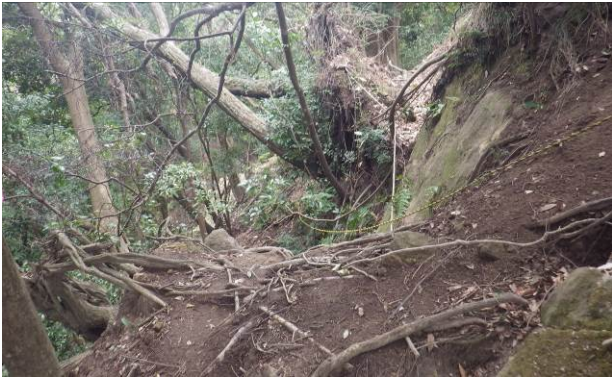
崩落個所のトラバース
