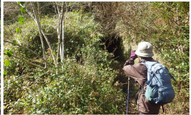
手掘りトンネル出口
