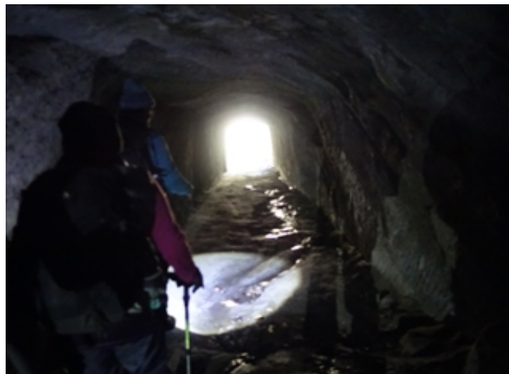
手掘りトンネル内
