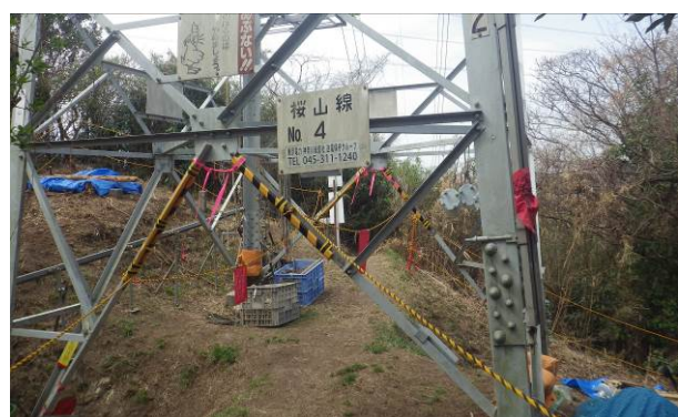
鉄塔の補修工事中
