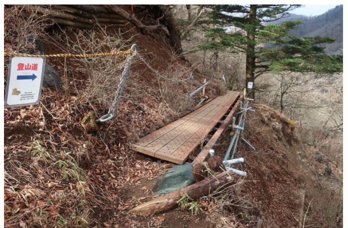
金山谷乗越の手前のトラバース道には 仮設足場が設置されていて安心だった
