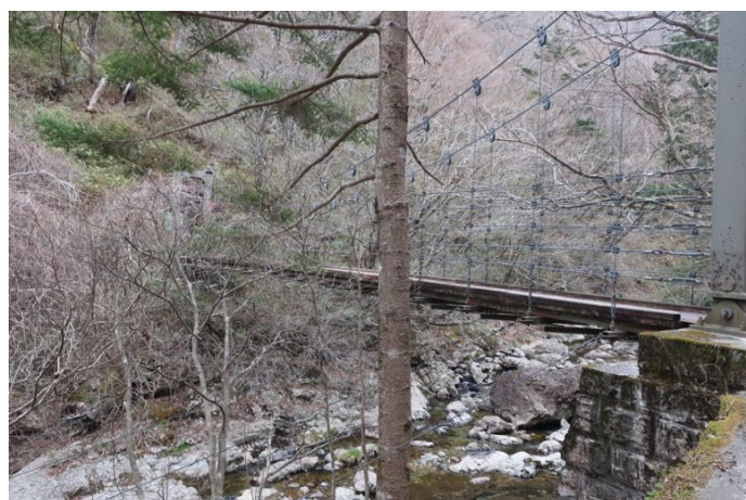
シオカラ谷吊橋 ここが本コースで一番低いところ 分岐より標高差で約 180m 下る 駐車場へはまた同じくらい登る
