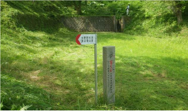
ダムを超えここから登る（コンクリートの作業道）
