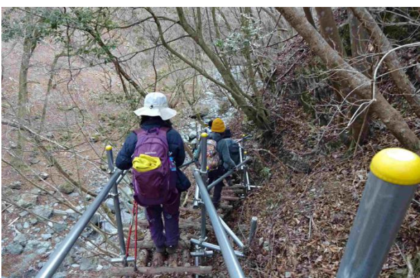
やがてパイプで組み立てた作業路で
