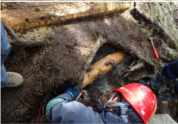
木の根、表面だけではなく、丸太の下部をしっかりと砂利で補強しないと、次期に土砂が流されてしまうとのことで表面上からは見えない箇所の作業が大切
