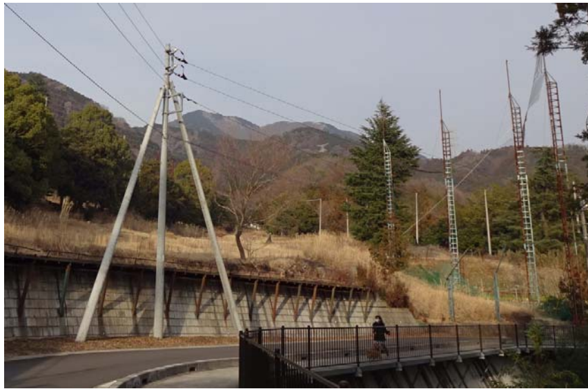
コースを縮小して営業 しているのか、ネットが 取り外され支柱が 赤く錆びついていた
